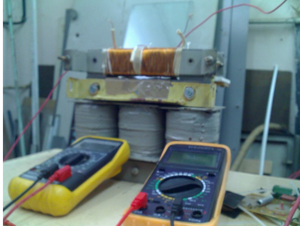
Рис. 2. Вид экспериментального комбинированного трехфазного трансформатора
